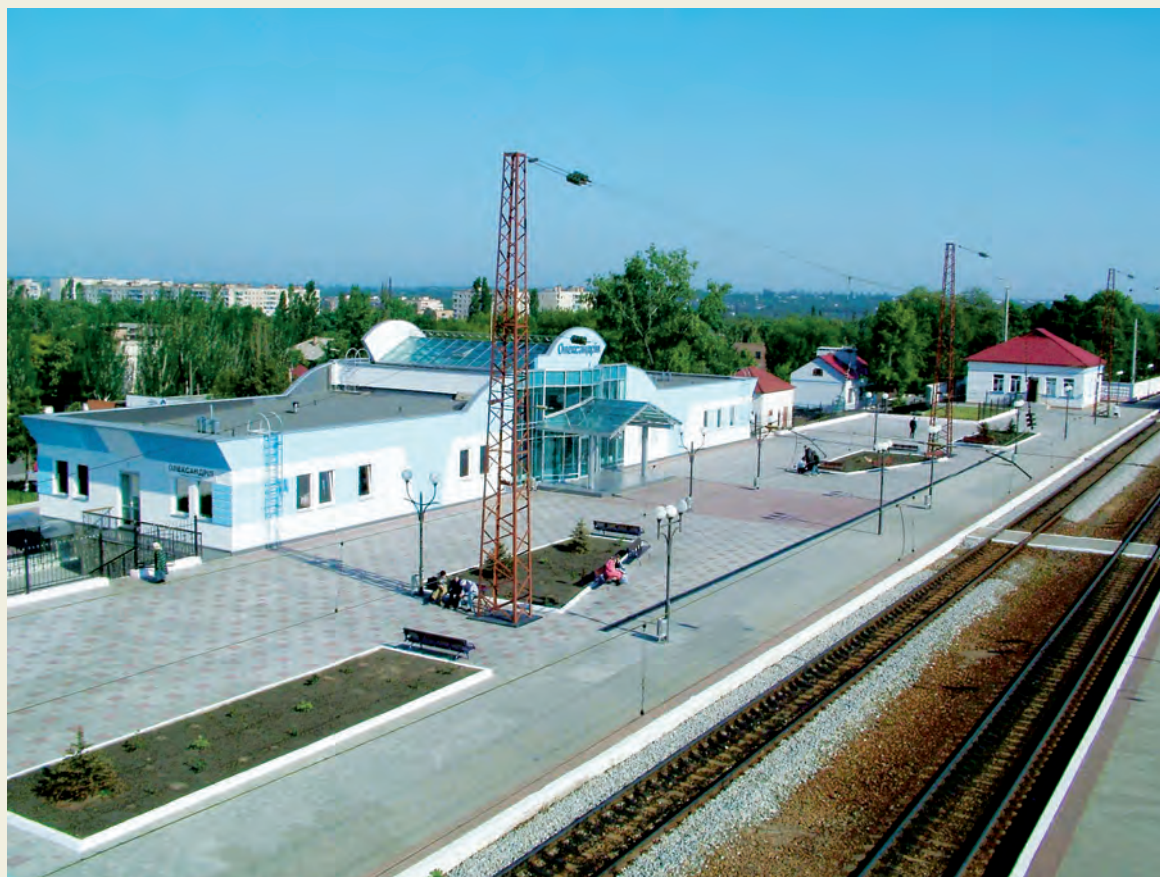
Залізничний вокзал станції Олександрія
