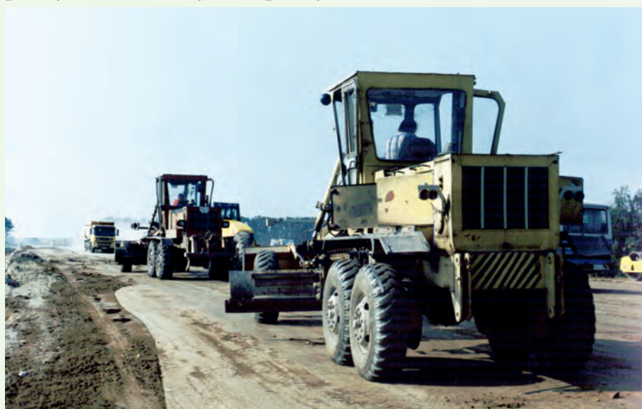
Будівництво автобану Київ–Одеса
